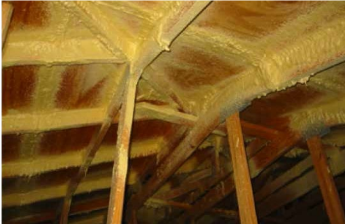
Figura 3.1: Aplicación de adhesivo de espuma de poliuretano en aerosol de celda cerrada a la parte inferior del revestimiento del techo
