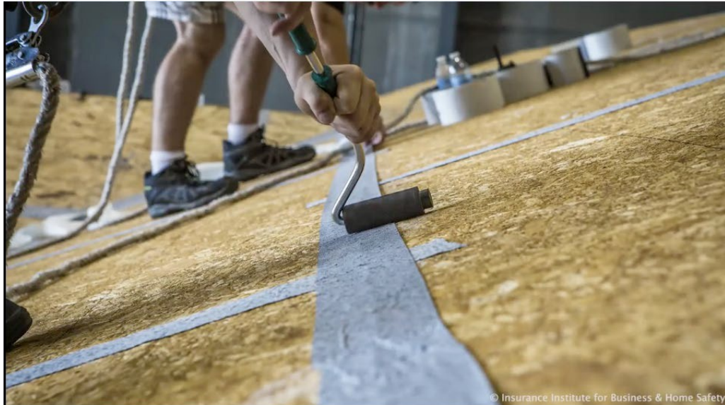
Figura 2: Instalación de un sistema de plataforma del techo sellada; colocación de cinta en las juntas del revestimiento del techo
