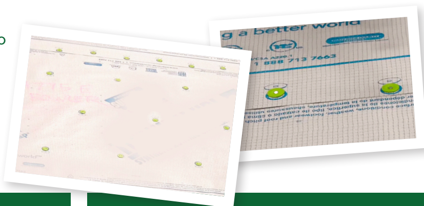
6" superposición en vueltas con 6" o.c., escalonada
